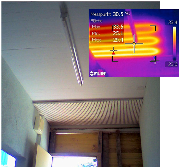
Erst im Infrarotbild sind die Deckenheizungsrohre gut zu erkennen.
